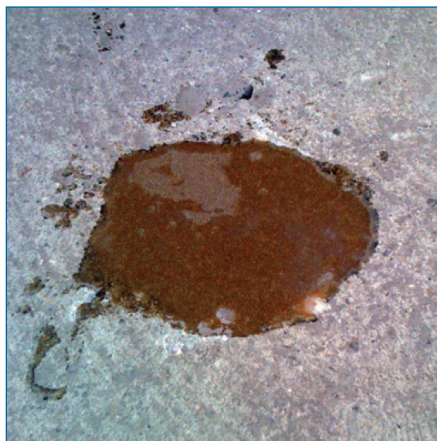
Etape 2 : Répandre le mortier sur la zone à traiter.
