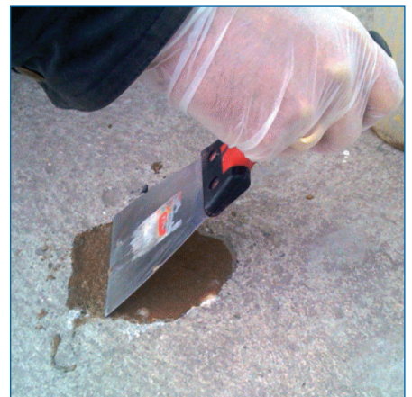
Etape 3 : Nivelier la surface avec une lisseuse.
