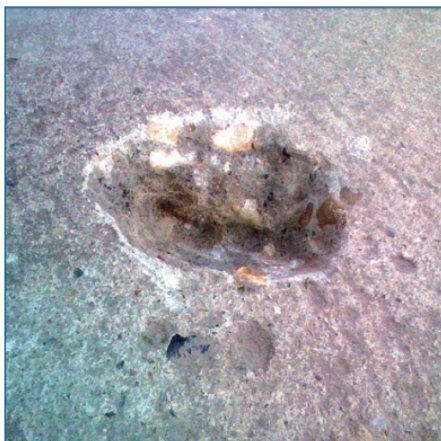
Etape 1 : Nettoyer la surface et préparer le mortier.
